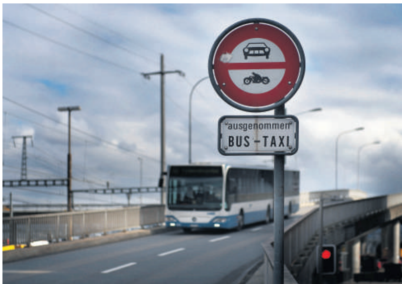
Busrampe beim Bahnhof Zürich Altstetten: Solche Vorhaben werden künftig aus dem NAF mitfinanziert.
